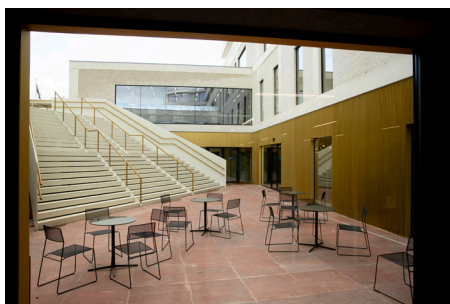
In de patio staat een indrukwekkende trap van twaalf ton staal die kan dienen als openluchttheater.
